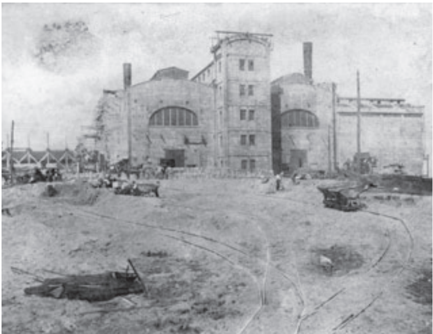
Central Tèrmica Catalana. Excavacions per a la construcció de sitges.
