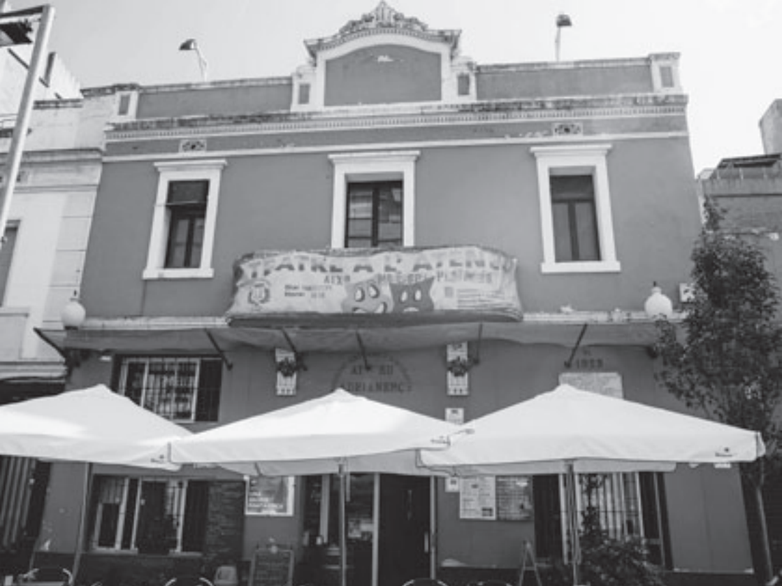
Edifici de l'Ateneu Adriànc.
