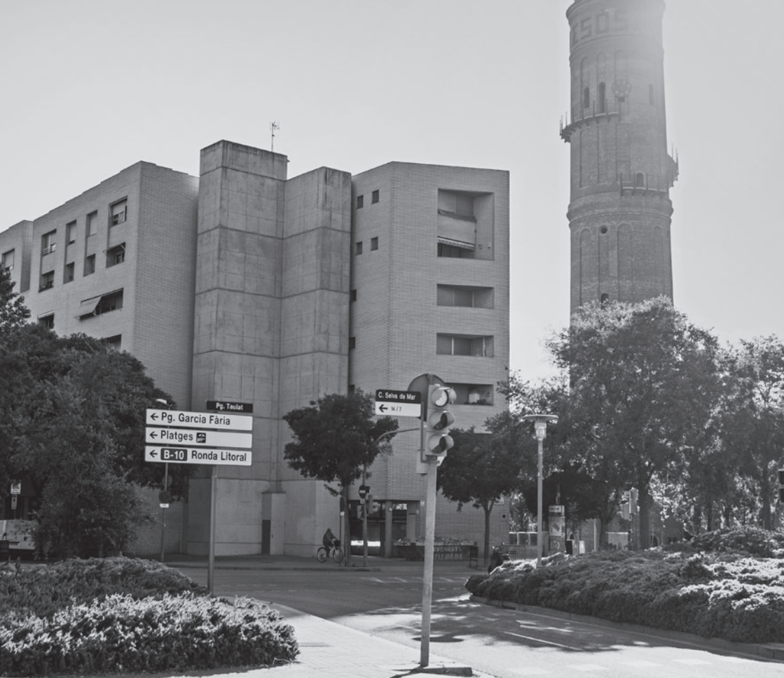
Vista de la Torre de les Aigües.
