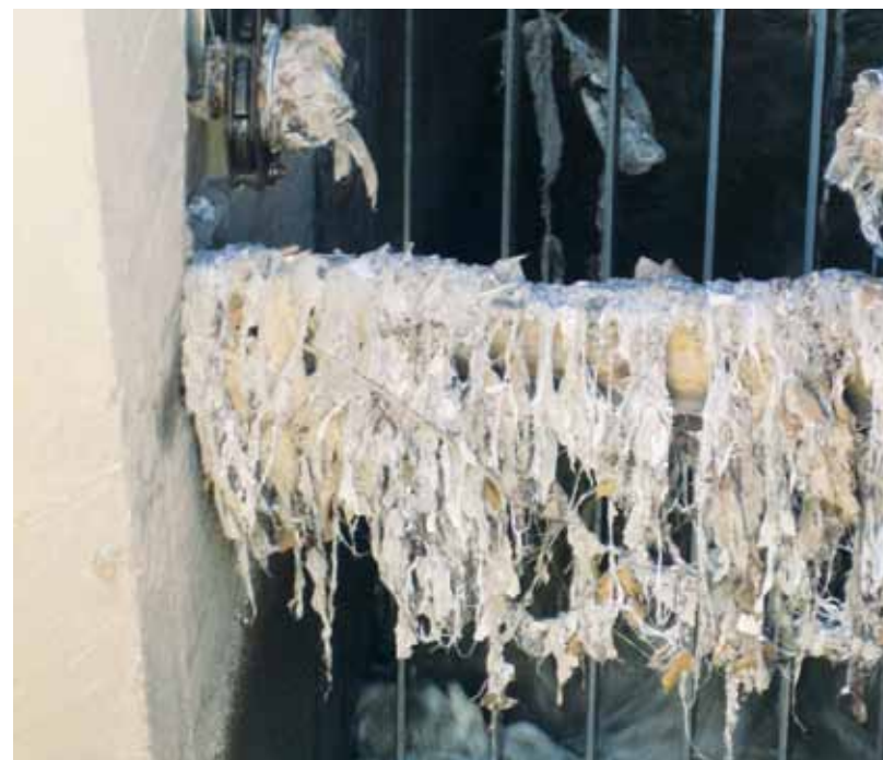
UNA IMATGE IMPACTANT Els residus sòlids poden arribar a afectar la funcionalitat de les reixes d'entrada d'aigua a les depuradores, ja que s'hi acumulen al llarg de la jornada..
