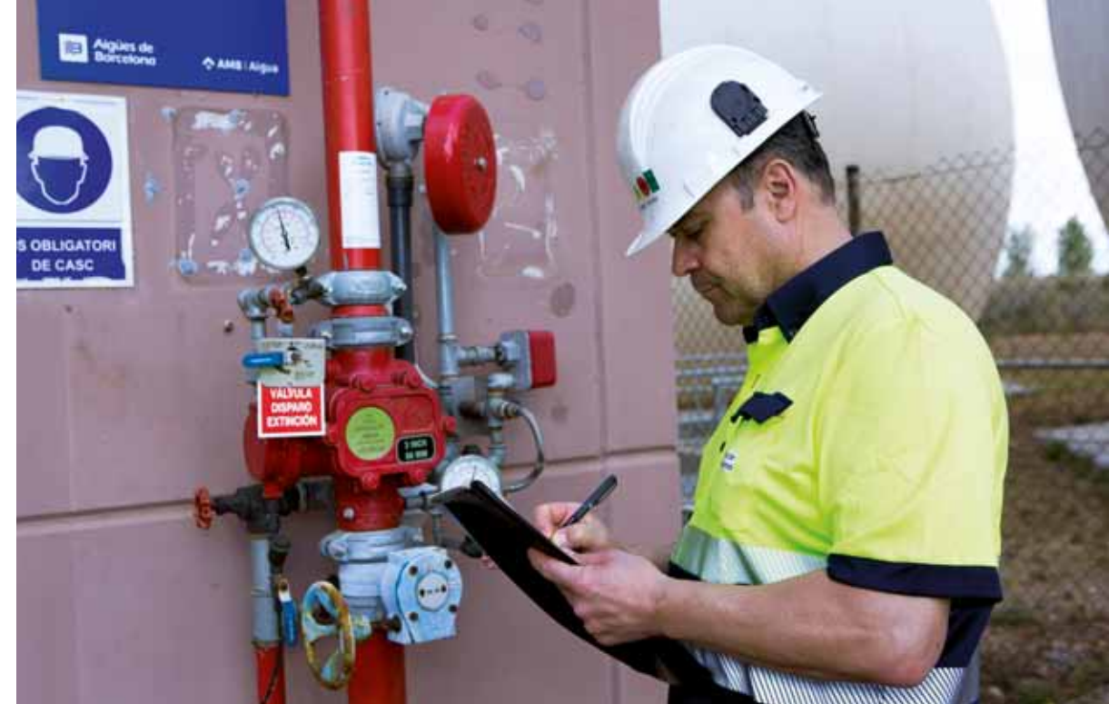
CONTROL CONTINU Un operari supervisa dades a la depuradora del Baix Llobregat.
