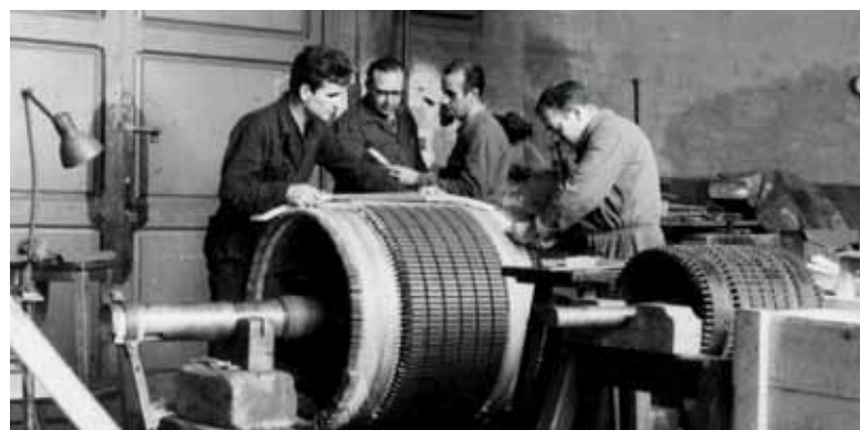
Esquerra: treballadors reparant una bobina, anys 1960. Dreta: l'evolució de la feina; buscador de fuites els anys 60-70 i operaris fent la mateixa activitat el 2014. Arxiu Associació de Treballadors d'Aigües de Barcelona.
