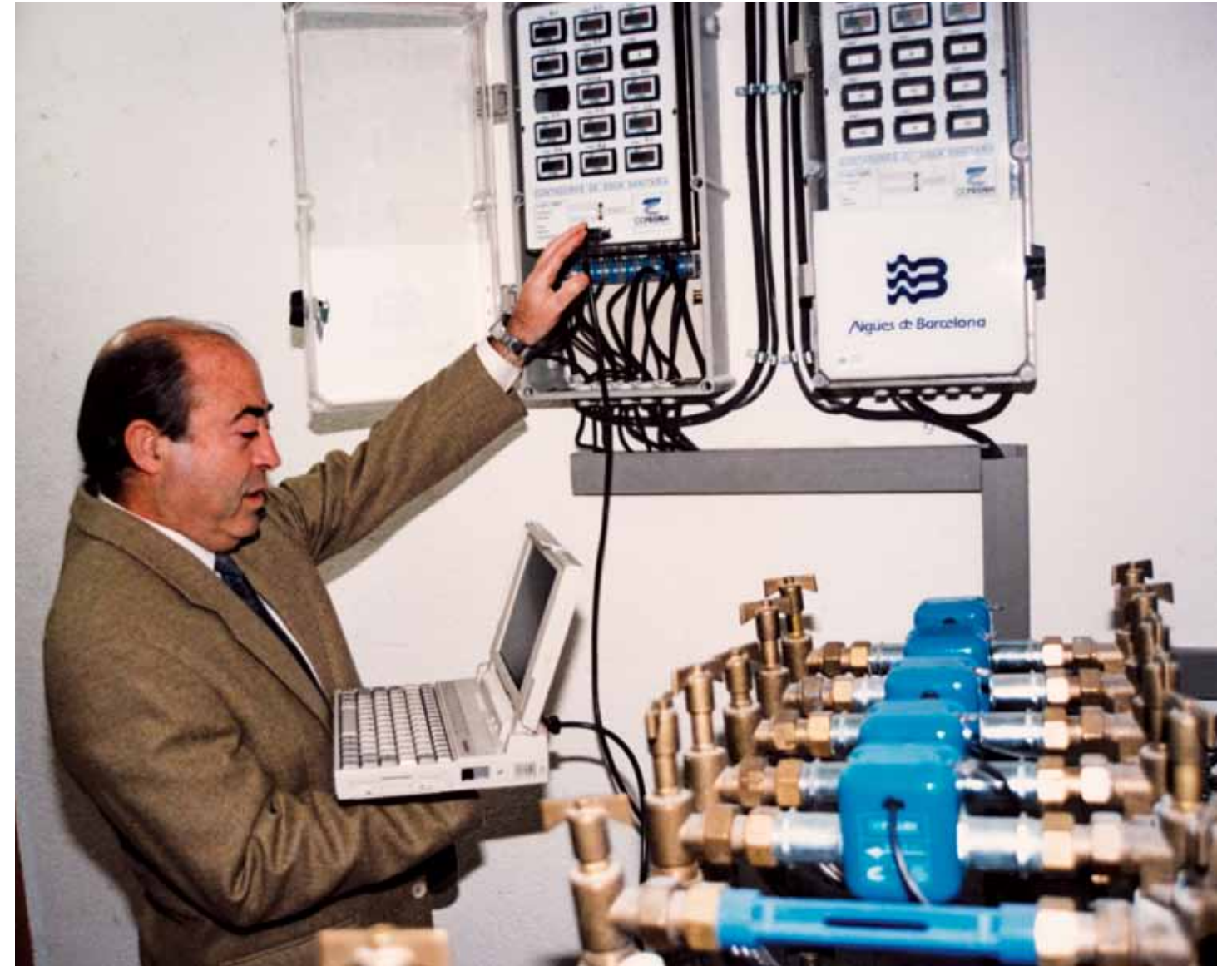
Instal·lació de comptadors intel·ligents individuals, cap al 1996. Arxiu Aigües de Barcelona.
