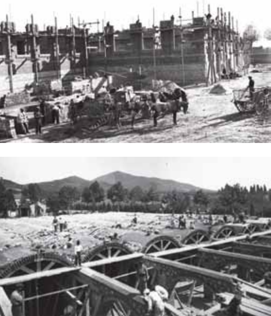
Construcció de la Central Cornellà i del dipòsit d'Esplugues, 1905. Arxiu Aigües de Barcelona.
