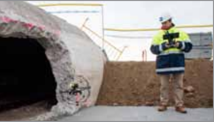
UNA INTERVENCIÓ EXEMPLAR A dalt, inspecció mitjançant un dron. A sota, l’obra pràcticament finalitzada després de la reparació del col·lector.
