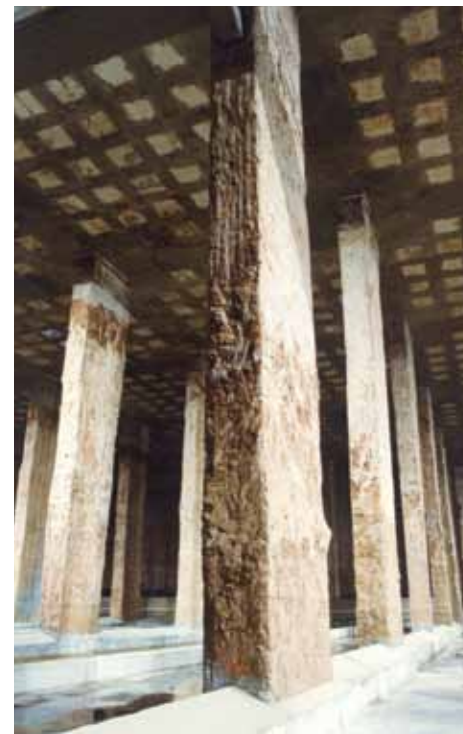
SOTA TERRA Columnes excavades en el terreny que sustenten la llosa que cobreix el dipòsit pluvial de Bori i Fontestà.
