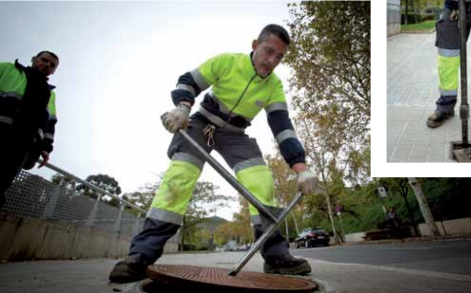
DESENVOLUPAMENT D'EINES L'experiència en el treball de camp ha servit per desenvolupar o modificar noves eines que fan més fàcil el treball diari. Un exemple és el prototip de la clau de maniobra. S'ha mecanitzat l'interior per millorar el seu ús a l'hora d'obrir i manipular tapes i vàlvules.
