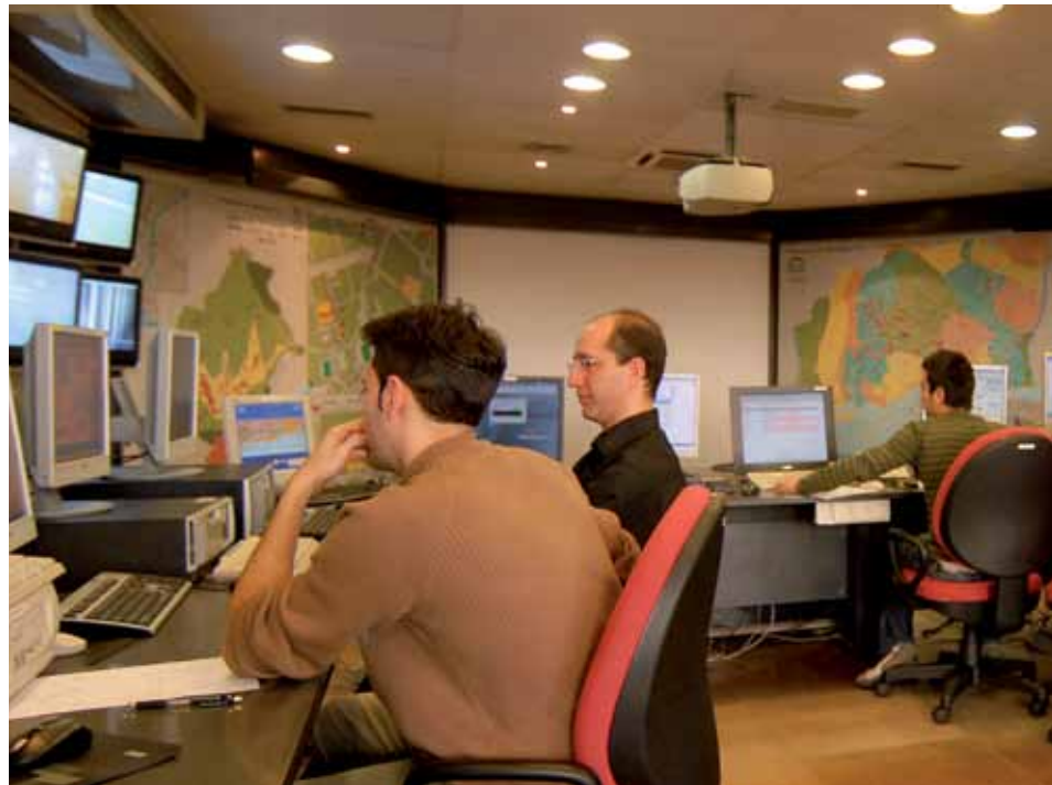
EL CENTRE DE CONTROL El sistema de control avançat de la xarxa de clavegueram i dels dipòsits pluvials permet un millor ús i un augment de la capacitat del sistema de drenatge de la ciutat.
