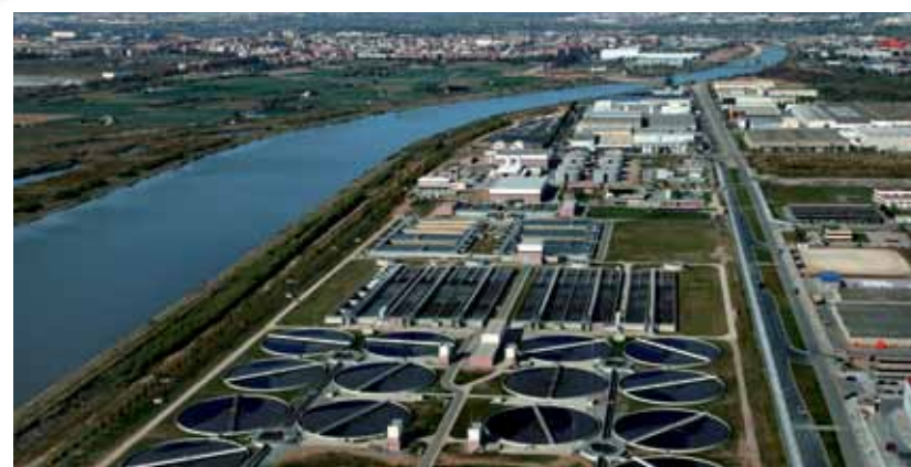
DEPURADORA DEL BAIX LLOBREGAT. És una de les instal·lacions de sanejament d'aigües residuals més grans i modernes d'Europa: tracta 315 milions de litres diaris. Té associada una Estació de Regeneració d'Aigües (ERA)
