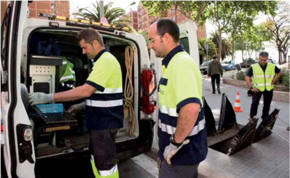
ÚS DE LA TECNOLOGIA Els operaris fan servir ordinadors portàtils per consultar les dades del cabalímetre i poder analitzar i configurar els elements de control.
