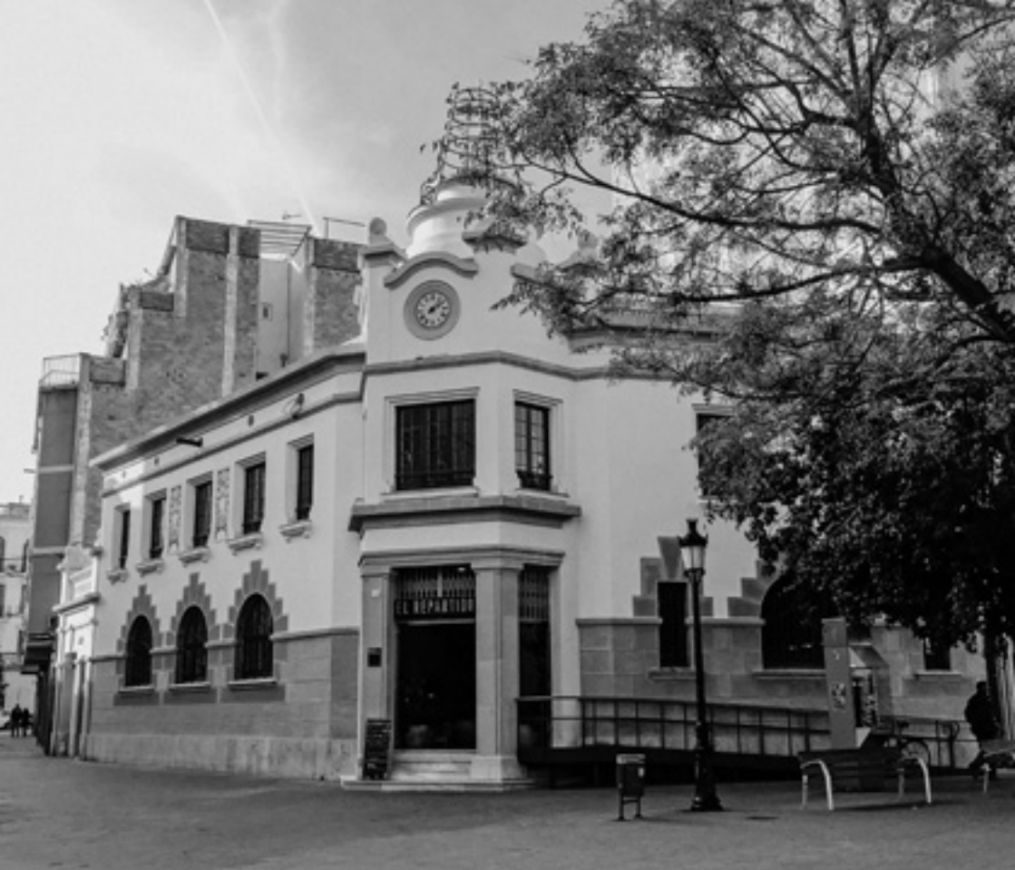
Antic edifici de Correus i Telègrafs on es troba la Fundació El Llindar.
