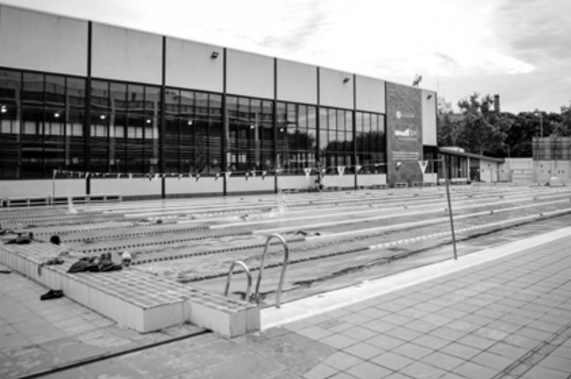
Instal·lacions del Club de Natació L'Hospitalet.
