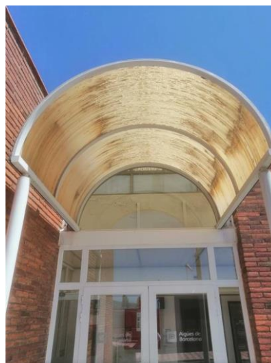
Lluernari entrada a les oficines de l'ETAP de SJD
