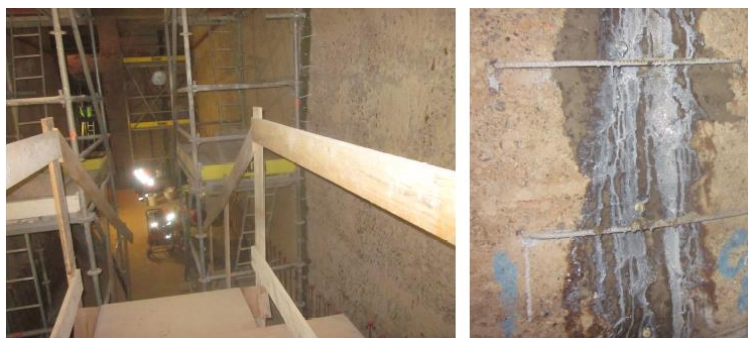
Obra en execució
