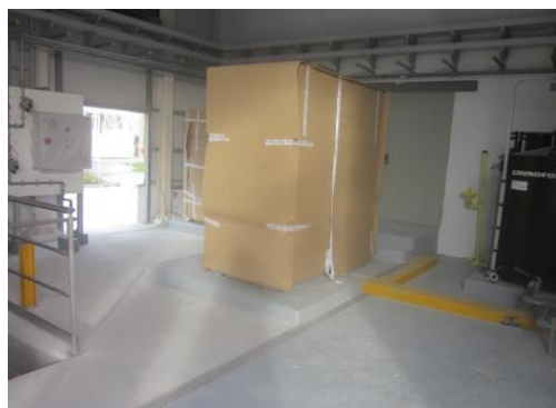
Instal·lació en construcció
