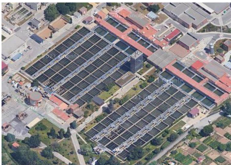
Decantadors de l'ETAP SJD
