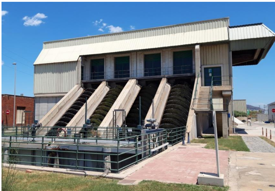
Cargols d'Arquímedes del bombament intermig de l'ETAP SJD
