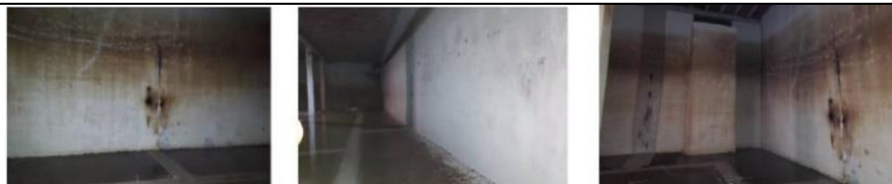
Vista interior del dipòsit C durant una neteja
