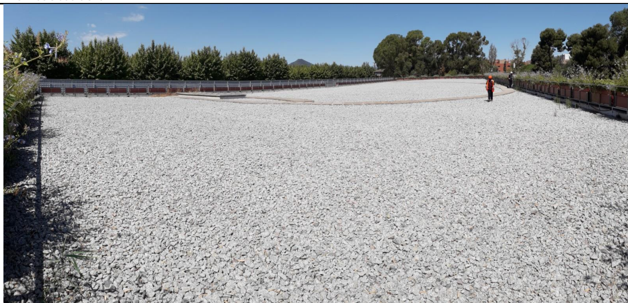
Coberta dipòsit Cornellà
