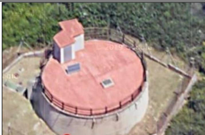
Vista aèria de la coberta del Dipòsit Santa Maria Montcada
