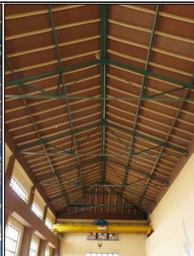
Estat actual coberta i paret (2 de 2)
