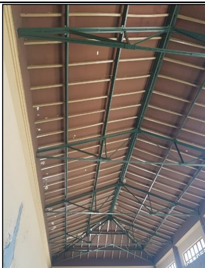
Estat actual coberta i paret (1 de 2)
