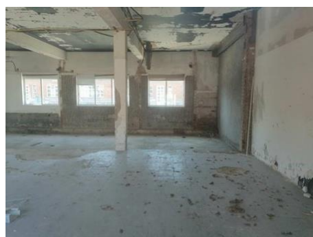
Espai a adequar dels vestuaris de l'ETAP de SJD
