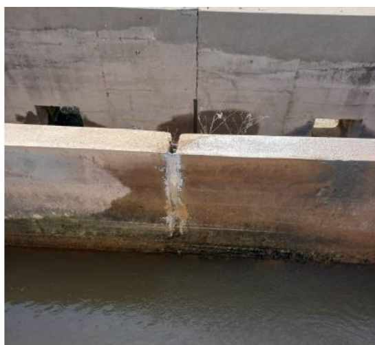
Canal de decantadors
