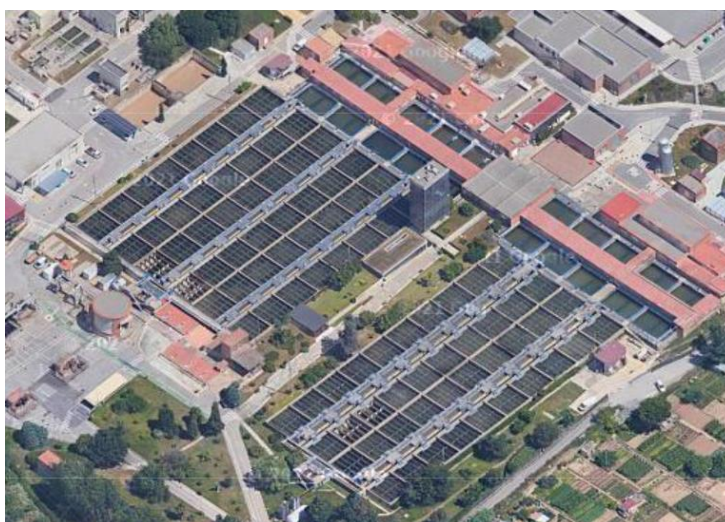
Decantadors de l'ETAP SJD
